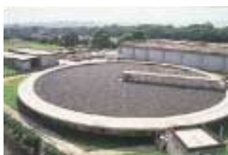
排水処理設備
