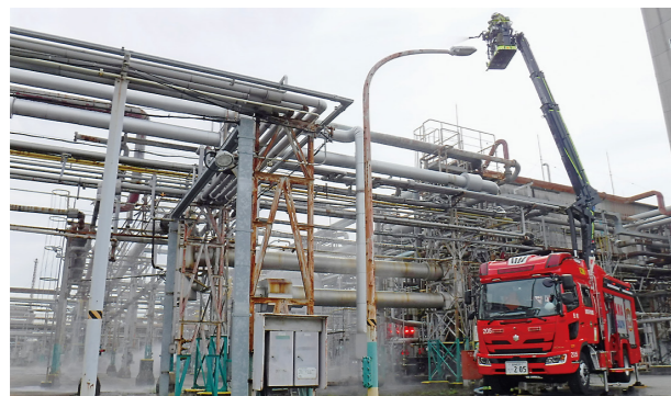
高所作業車による放水
