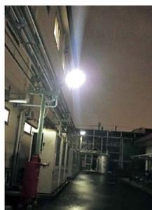
夜間自動点灯後、人感センサー検知により照度アップ
