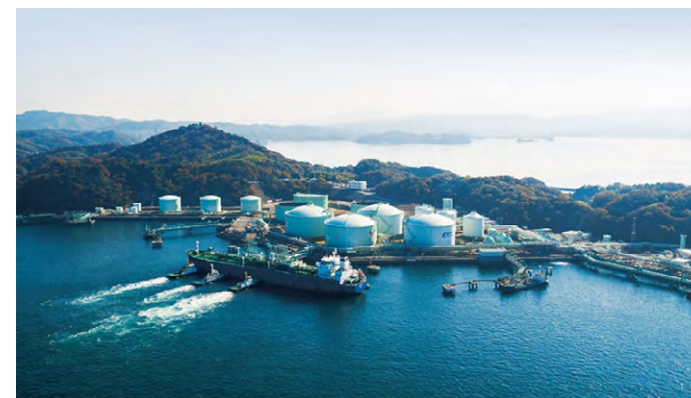
波方ターミナル株式会社が運営する既設ターミナル(愛媛県今治市)
